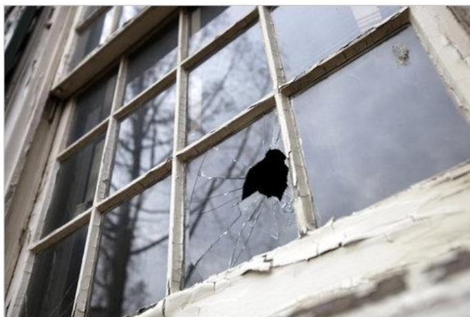
Слика бр.22. Скршен прозор на напуштен објект.
