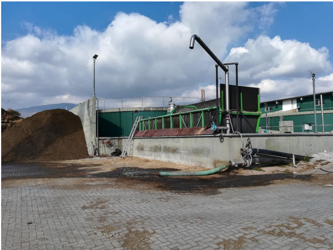
Слика бр. 10 Место за полнење на супстрат (во горен дел се носи со машина за товарање цврст супстрат, а во долен дел на цревето, се пумпа течен супстрат)
