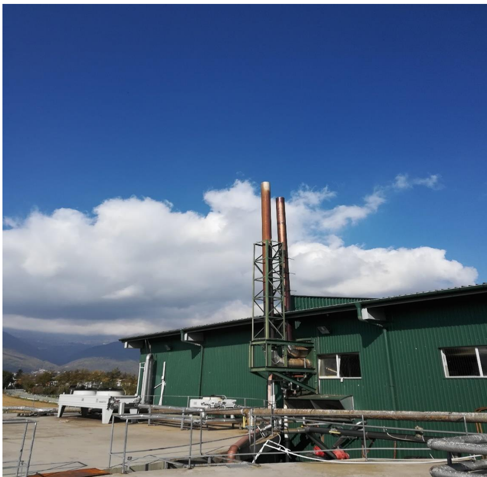
Слика бр.18 Издувен дел за испуст на отпадните гасови при константна работа на моторите и согорување на биогазот во биогазната постројка
