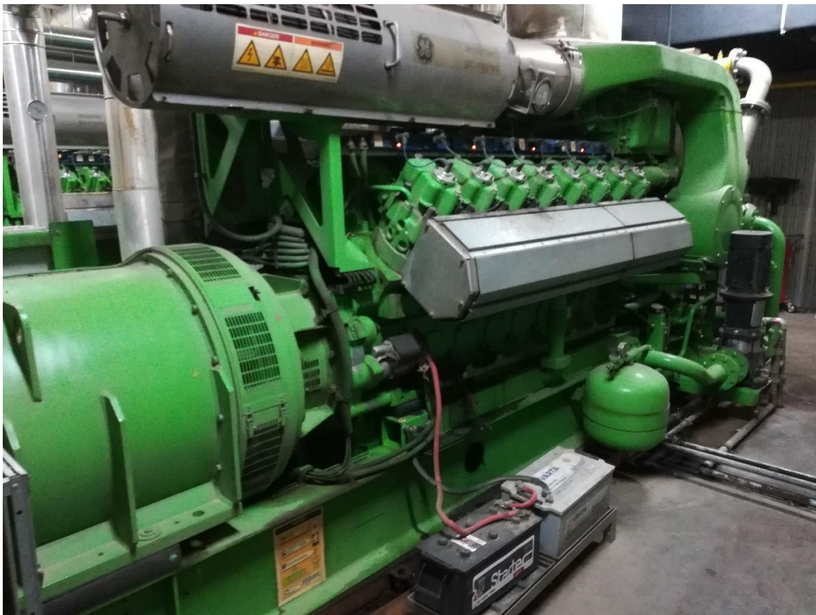
Слика бр. 19 Мотор – генератор на електрична енергија кој за гориво користи биогаз (метан) стационаран во биогаз централата Електро Шари – с. Требош – Тетово – Р.Македонија
