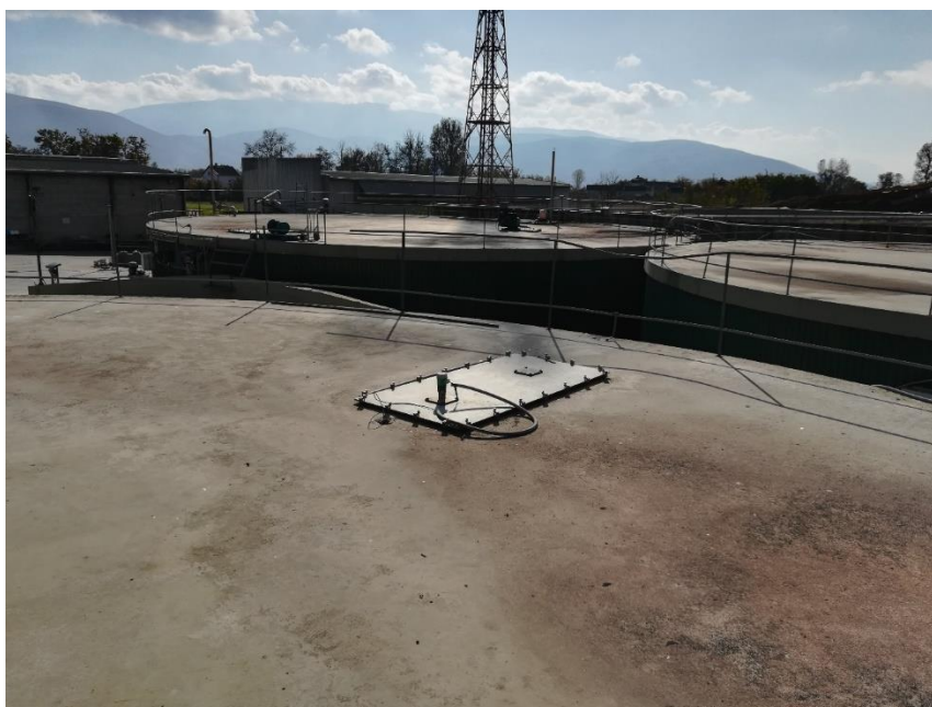
Слика бр.17 Сонда за следење на температурата и грејни тела за догревање на супстратот во биодигесторот (Електро Шари с.Требош – Тетово – Р.М. 2020 година)
