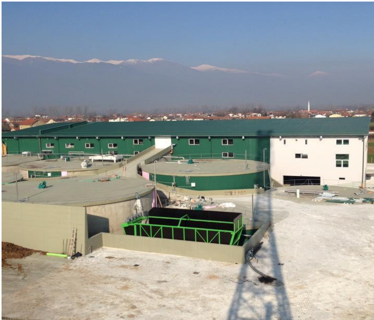
Слика бр. 16 Резервоари од армиран бетон и резервоари од челична конструкција за ферментација на суровина и производство на биогаз во биогазната централа „ЕлектроШари“ с. Требош – Тетово, Р.С. Македонија
