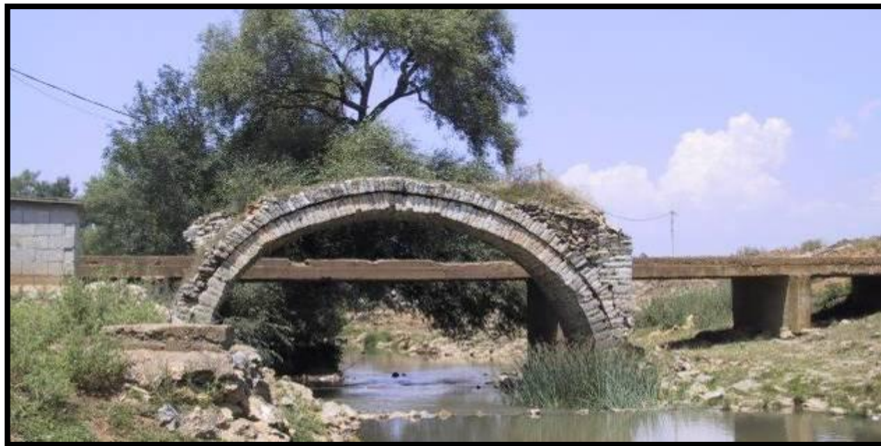
Слика бр 27: Мостот на Арабаците во Бубел
