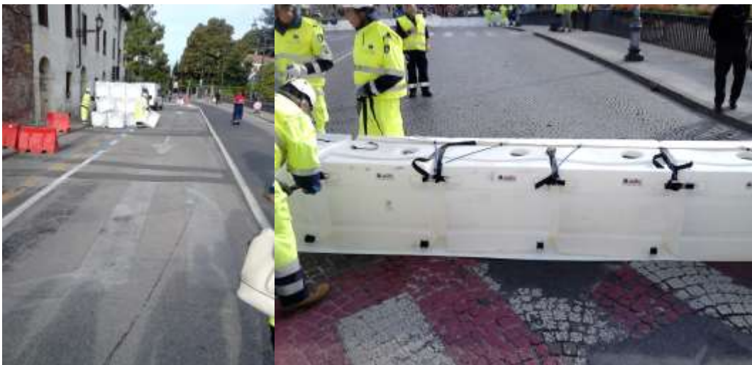
Слика 1: Поставување на модулarna водена брана (анг. aquadike) - Виченца (Италија)
